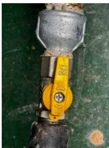
**Gas-Zuleitung für beide Häuser:** Im Garten an der Steinwand zur zweiten Ebene befindet sich eine Gaszuleitung zu den beiden Häusern. Gelber Hebel senkrecht = Leitung geöffnet, waagrecht = .geschlossen.
